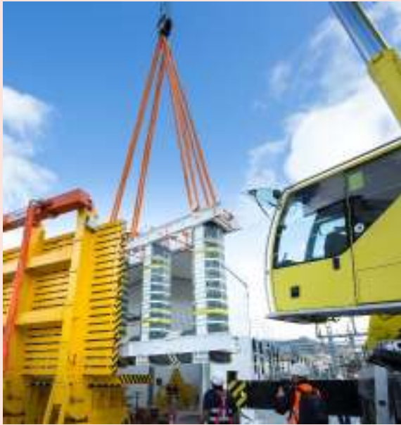
Mise en loges des transformateurs
